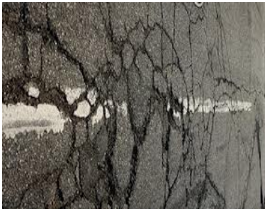
Рис. 3. Сетка трещин
