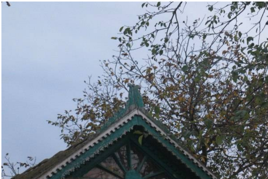
Рисунок 8 Обереги на даху будівлі
